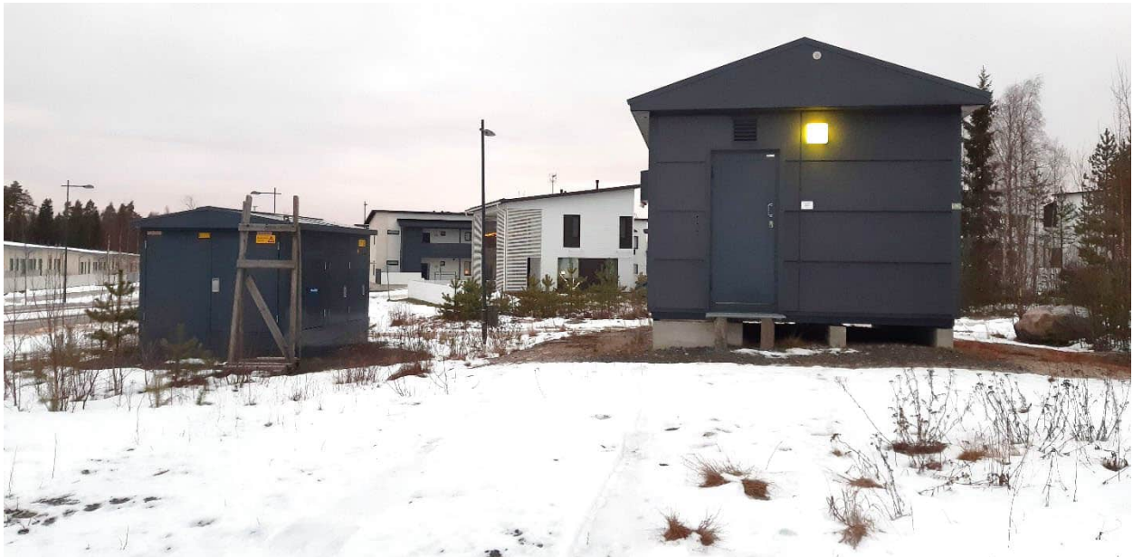
Kuva 5 Asemakaavan muutosalueen lounaisosassa sijaitsee muuntamo (oikealla) sekä operaattorin laitetila (vasemmalla).
