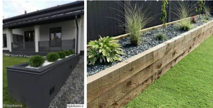
Aidan yhteyteen rakennettavan istutusaltaan ei tarvitse olla korkea ja reuna voidaan esim. valaa betonista tai latoa muurikivistä, aidan tyypistä riippuen.
